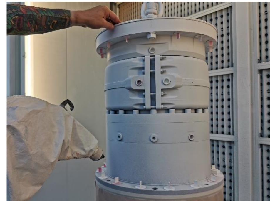
Lackieren des fertig sanierten Aggregats
